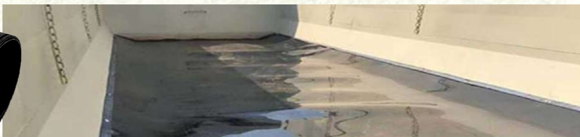
MANTA PEAD / CAÇAMBA
